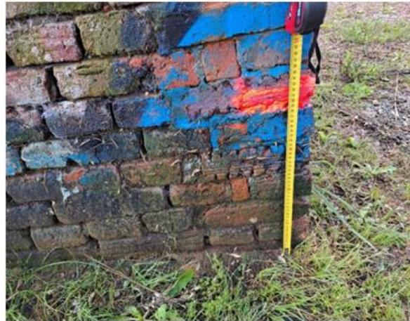
2. Esquina NW del edificio
