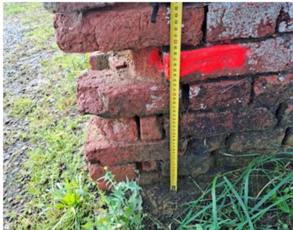
3. Esquina NE del edificio
